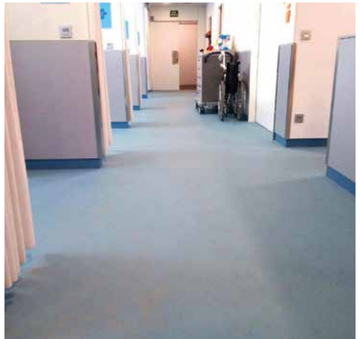
REVÊTEMENT DE SOL ZONE HOSPITALIÈRE, ANDORRE, 400 M 2
