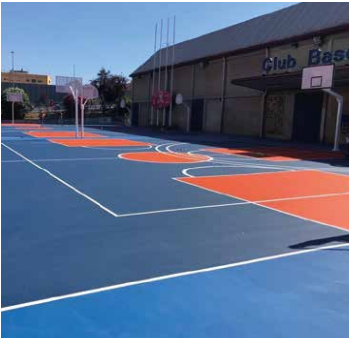
REVÊTEMENT DE SOL CLUB SPORTIF, GRANOLLERS, ESPAGNE, 400 M 2
