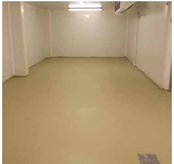
SALLE DE TRANSFORMATION FRIGORIFIQUE, FRANCE, 1.400 M 2
