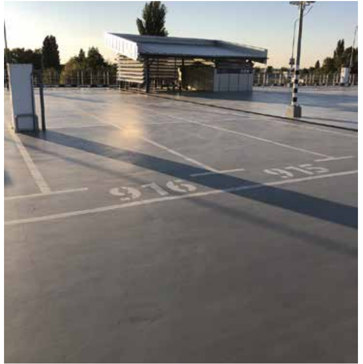
REVÊTEMENT DE SOL PARKING, AÉROPORT BORISPOL, UKRAINE, 30.000 M 2
