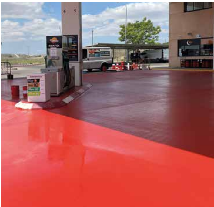
REVÊTEMENT DE SOL STATION-SERVICE, MADRID, ESPAGNE
