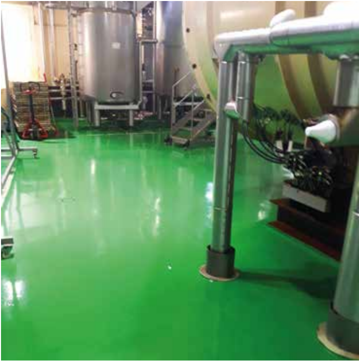
REVÊTEMENT DE SOL ZONE INDUSTRIELLE, BARCELONE, 2.500 M 2
