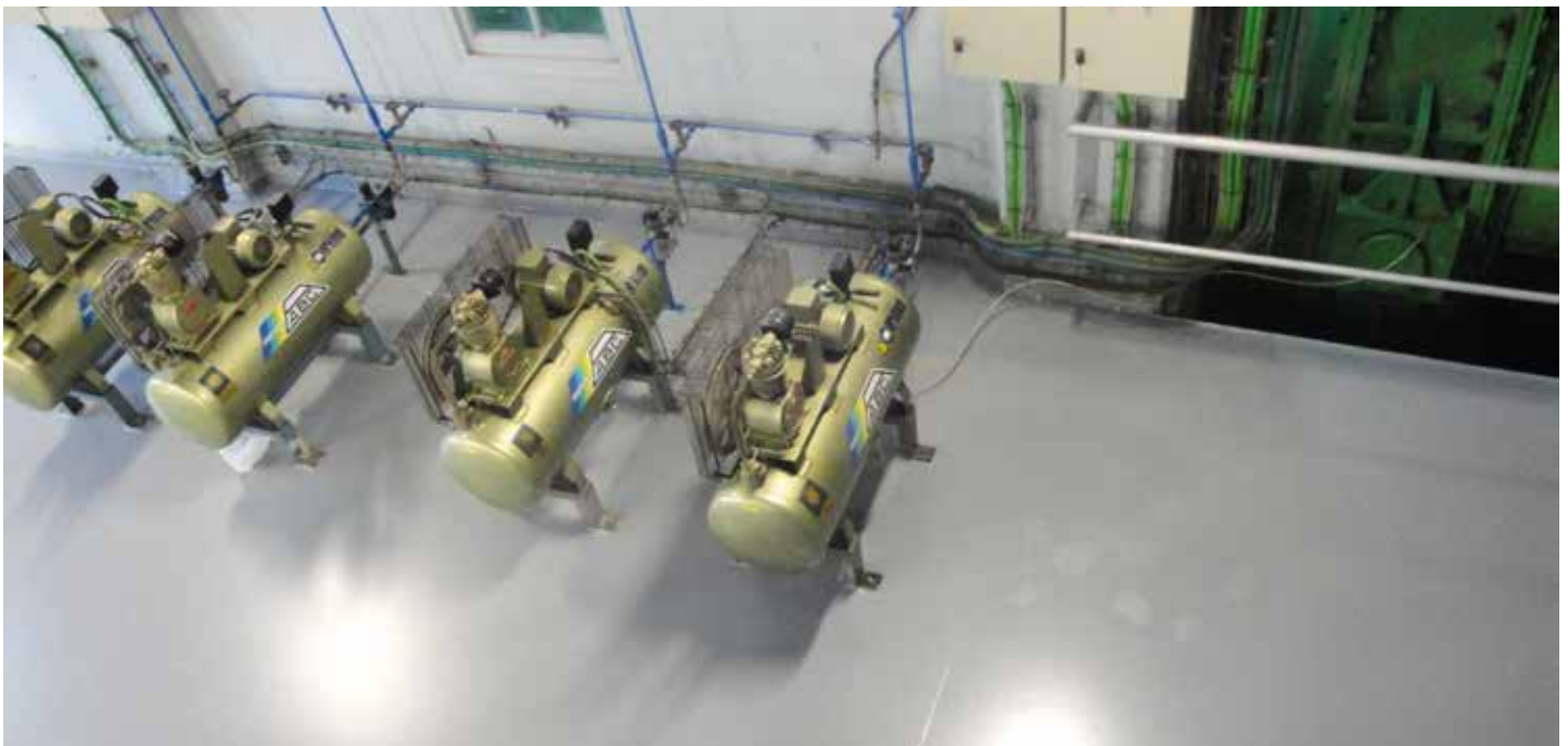
REVÊTEMENT DE SOL CENTRALE HYDROÉLECTRIQUE, SERÒS, LLEIDA, ESPAGNE, 800 M 2
