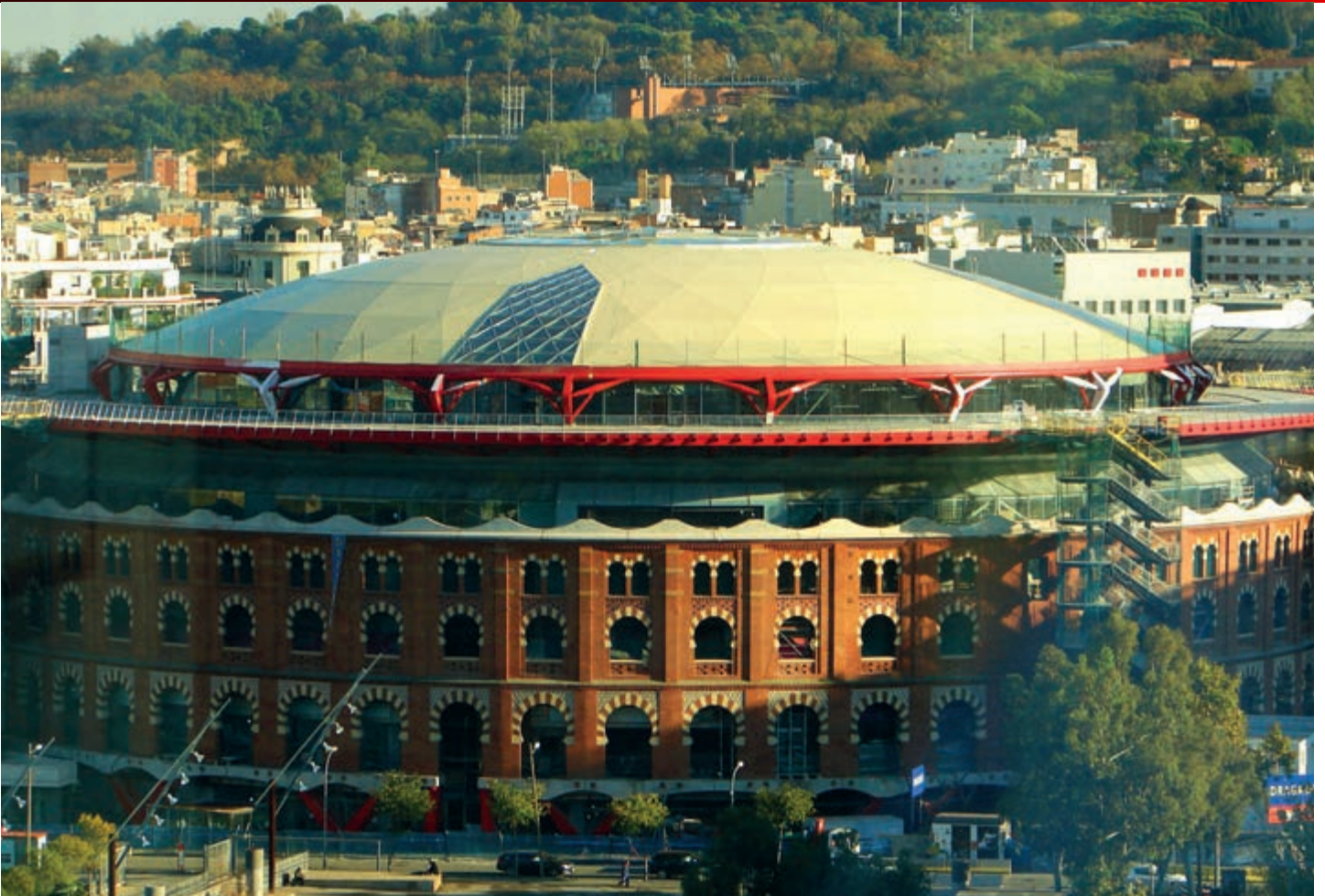
CUBIERTA CENTRO COMERCIAL LES ARENAS, BARCELONA, 4.182 M 2
