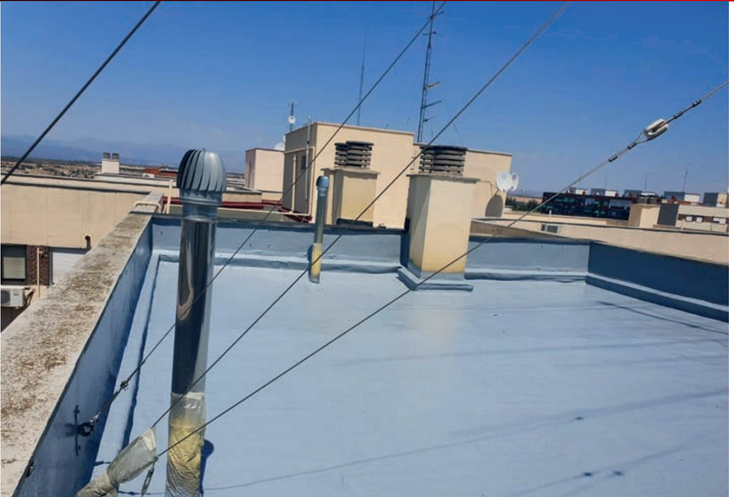
CUBIERTA AISLAMIENTO TÉRMICO Y ACÚSTICO, MADRID, 1.000 M 2
