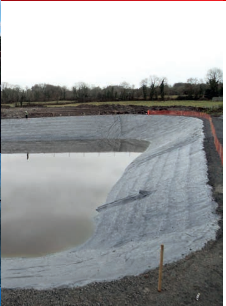
(IZQ) IMPERMEABILIZACIÓN ESTANQUES DE AGUA, PARQUE WARNER, MADRID, 1.500 M 2 (DER) IMPERMEABILIZACIÓN LAGO DE TORMENTA, IRLANDA, 4.000 M 2
