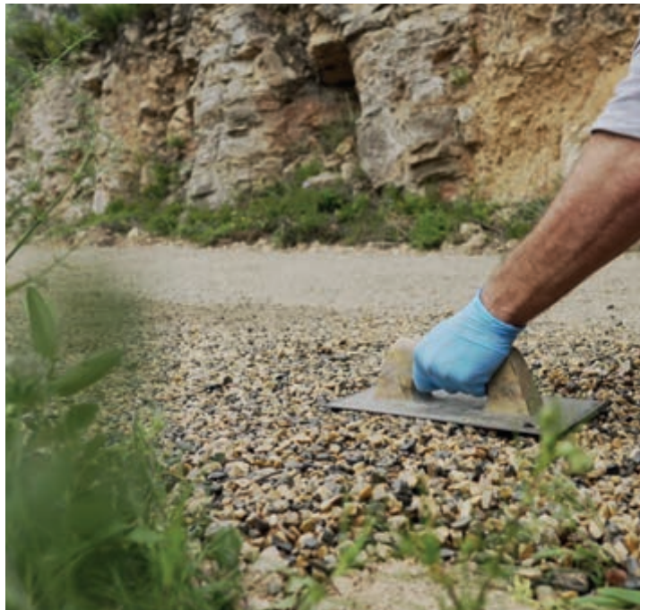
PAVIMENTO EN CAMINO PERI-URBANO, VANDELLÒS
