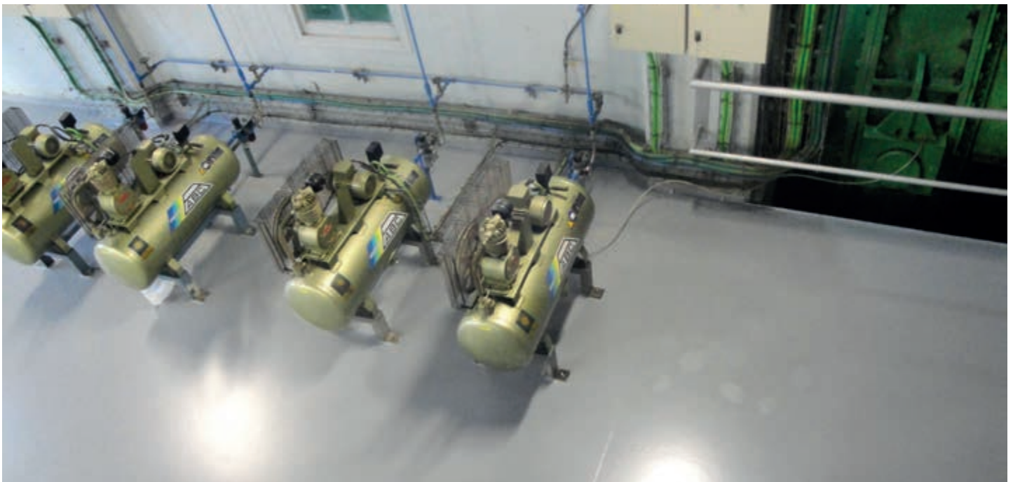
PAVIMENTO CENTRAL HIDROELÉCTRICA, SERÒS, LLEIDA, 800 M 2
