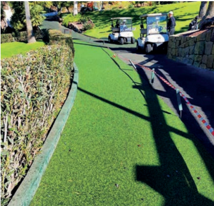
PAVIMENTO CAMPO DE GOLF, CATALUÑA, 500 M 2
