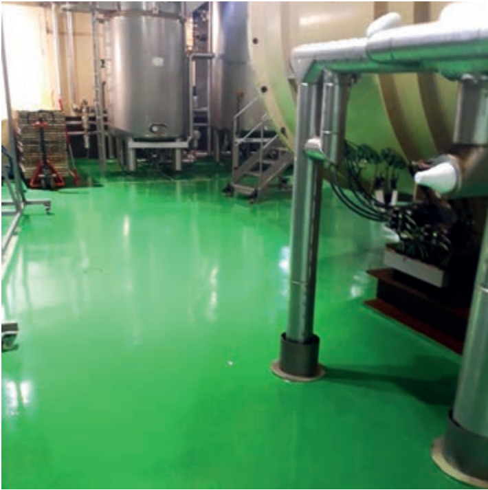
PAVIMENTO ZONA INDUSTRIAL, BARCELONA, 2.500 M 2
