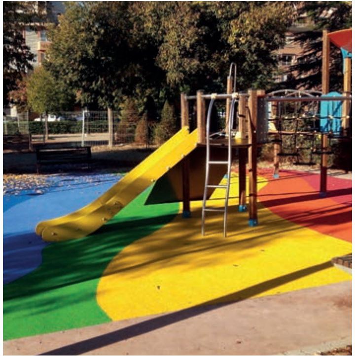
PAVIMENTO PARQUE INFANTIL, GRANADA, 200 M 2
