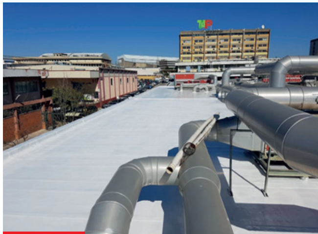
Impermeabilización Cubierta edificio Aeropuerto de Lisboa
