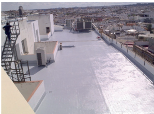
Cubierta edificio de viviendas en Andalucía.
