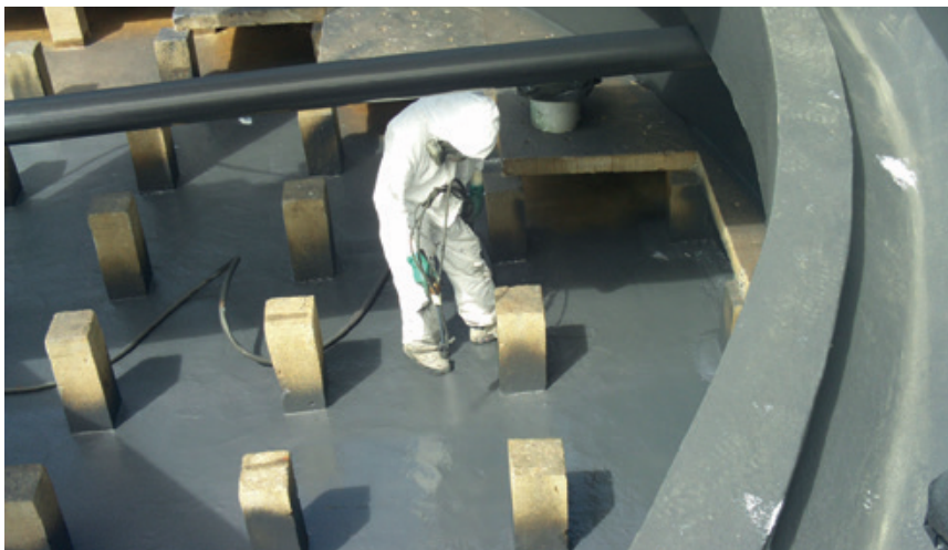
Aplicación de un revestimiento impermeabilizante de poliurea en un tanque de tratamiento de agua residual en una EDAR.
