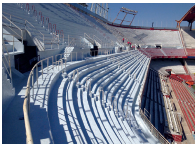
Impermeabilización gradas del estadio de Fútbol del F. Club Sevilla
