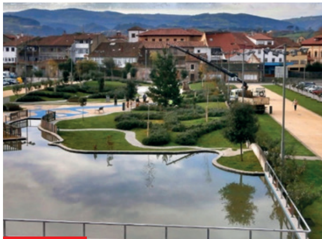
Impermeabilización de estanque de drenaje de aguas pluviales en el Parque del Pelambre. Villaviciosa, Asturias.
