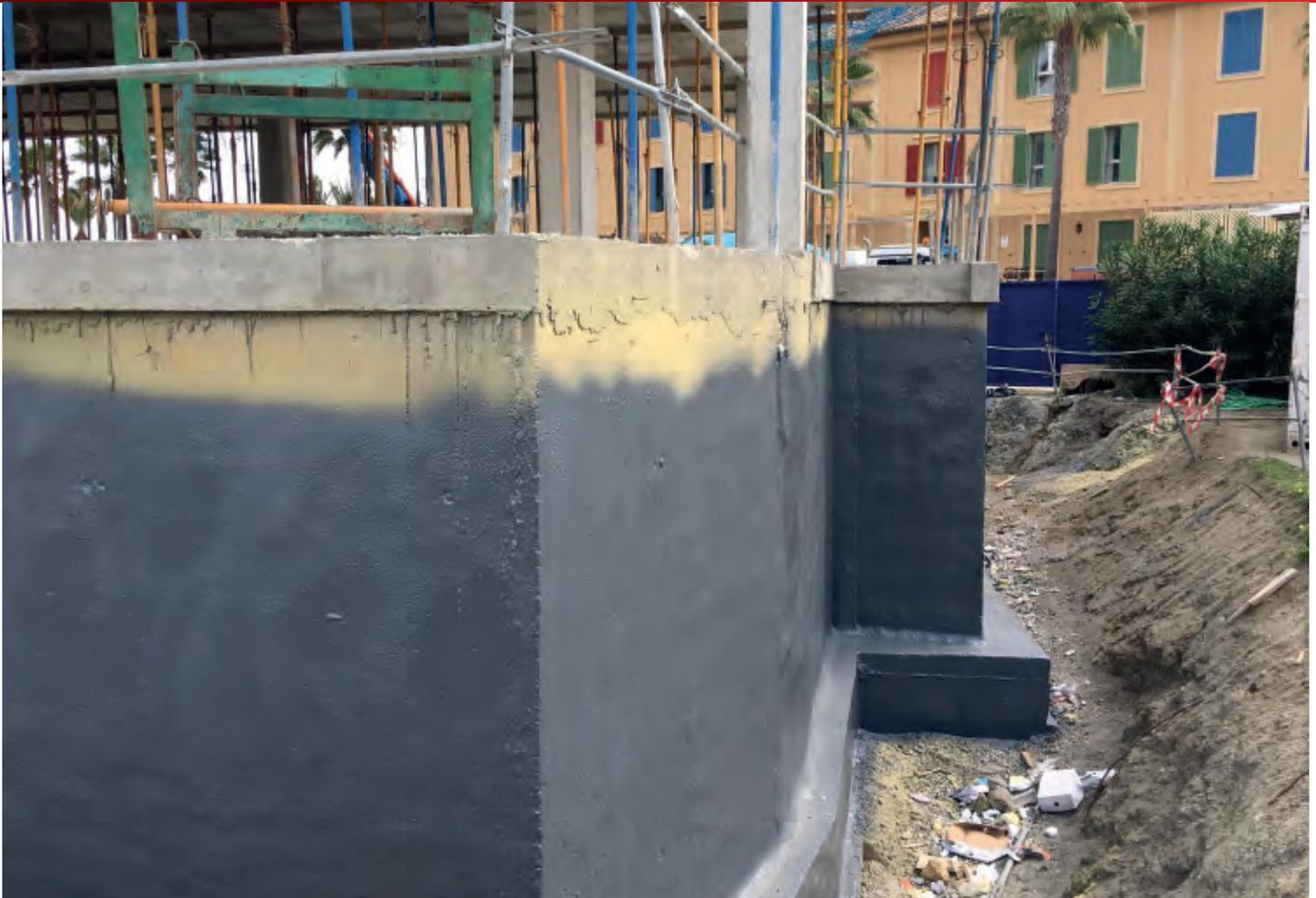
IMPERMEABILIZACIÓN Y BARRERA AL GAS RADÓN, 800 M<sup>2</sup>
