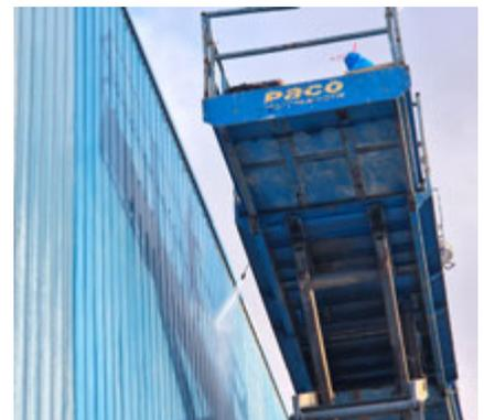
Fig. 2. Preparación de la superficie y pintado.
